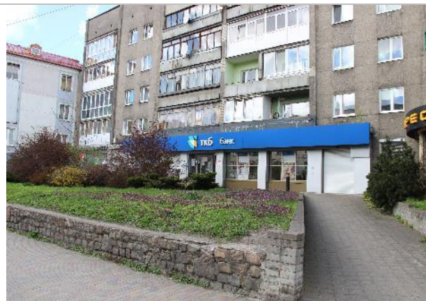
Фотография 3.2. Внешнее состояние объекта
