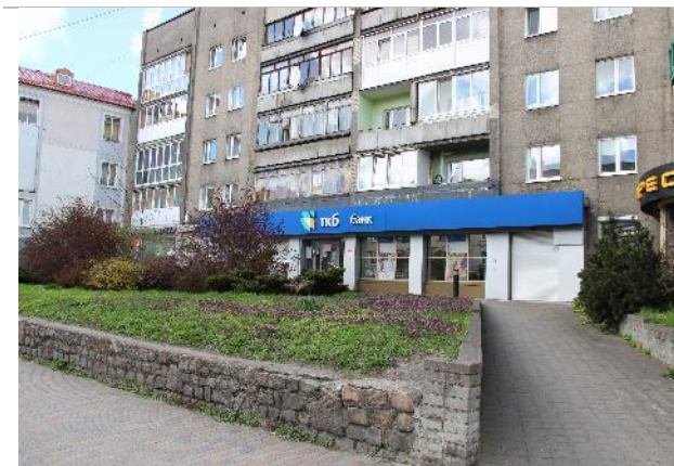
Фото 1. Внешнее состояние объекта
