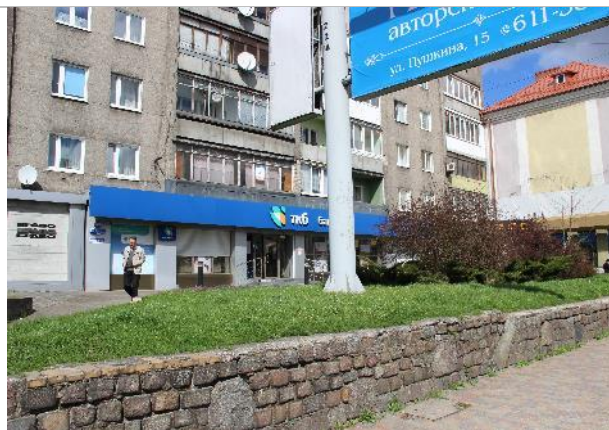
Фото 2. Внешнее состояние объекта
