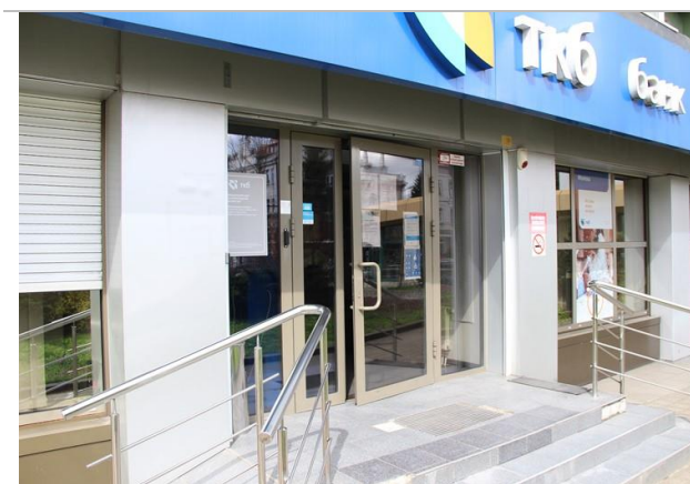
Фото 3. Внешнее состояние объекта
