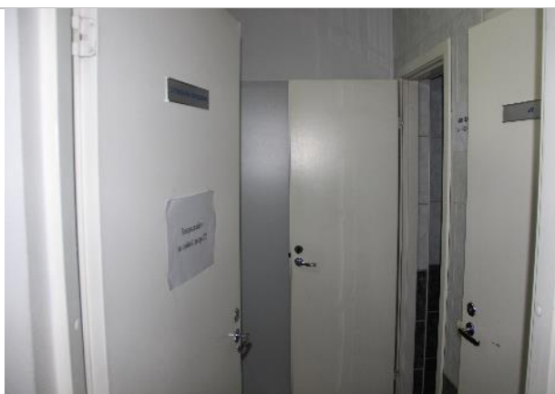
Фото 12. Фрагменты внутренних помещений
