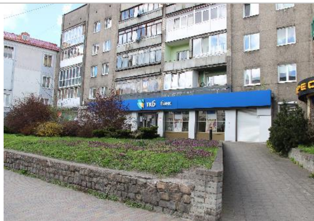
Фотография 3.1. Внешнее состояние объекта
