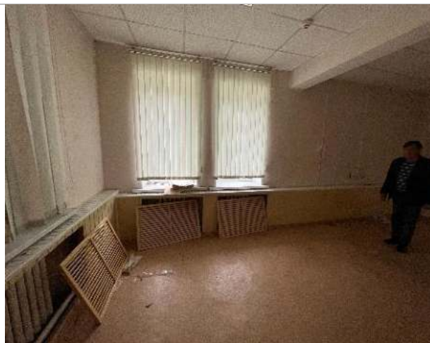
Фотография 41. Внутренние помещения здания
