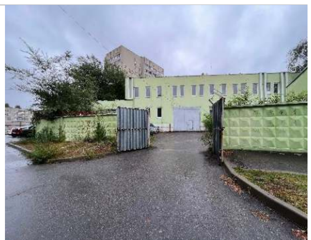
Фотография 6. Гараж, подъездные пути
