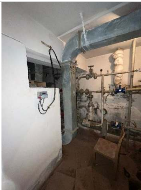
Фотография 20. Внутренние помещения здания
