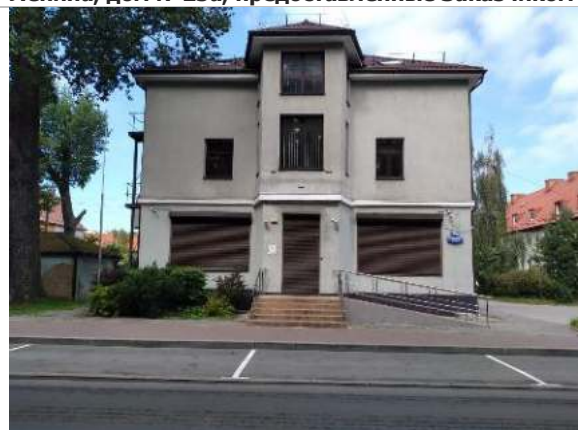
Фотография 1. Внешнее состояние объекта.
