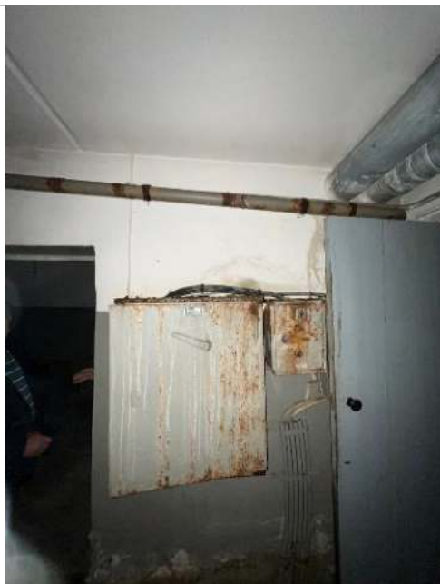
Фотография 19. Внутренние помещения здания
