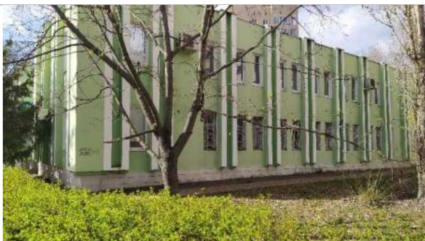
Фотография 3.18. Фасад административного здания
