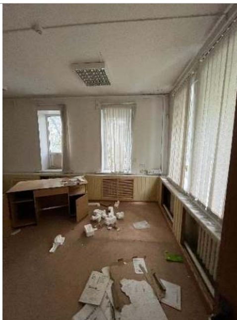
Фотография 58. Внутренние помещения здания
