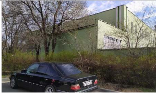
Фотография 5. Фасад здания
