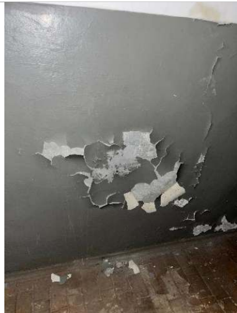
Фотография 16. Внутренние помещения здания
