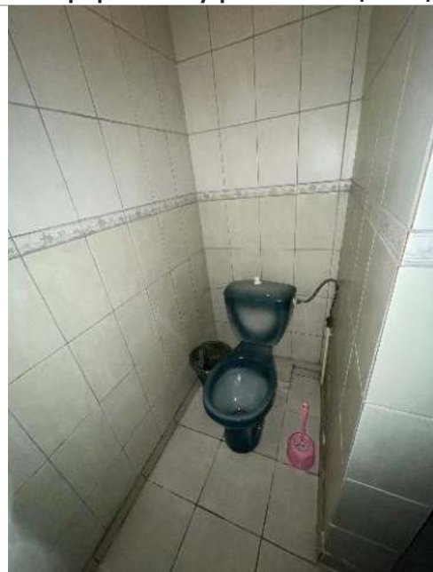
Фотография 35. Внутренние помещения здания
