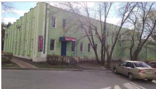
Фотография 4. Фасад здания
