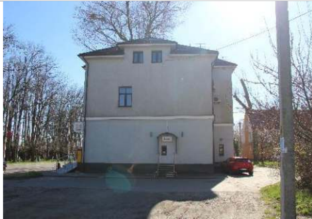
Фотография 5. Внешнее состояние объекта.
