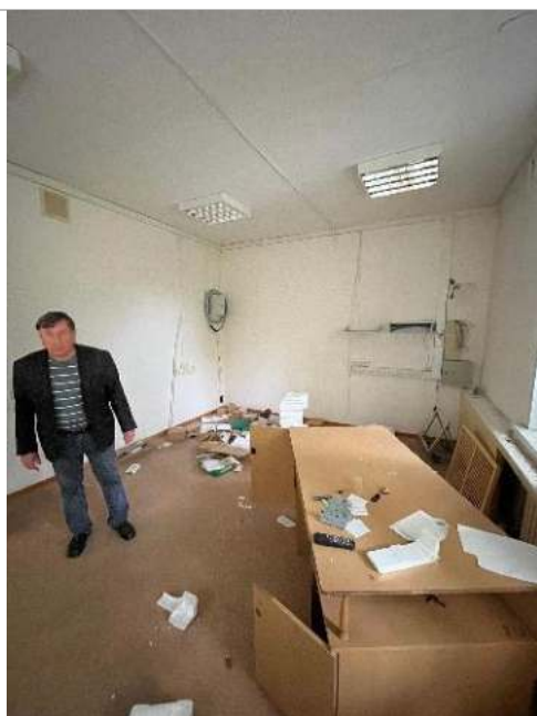
Фотография 59. Внутренние помещения здания
