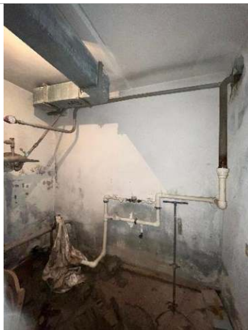
Фотография 21. Внутренние помещения здания
