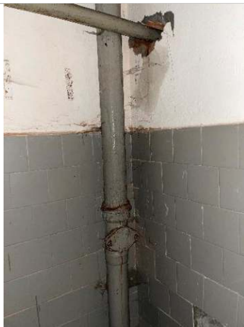
Фотография 22. Внутренние помещения здания
