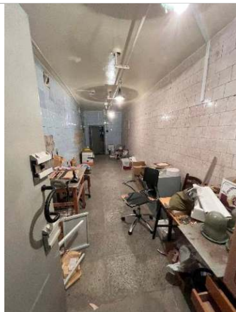
Фотография 33. Внутренние помещения здания
