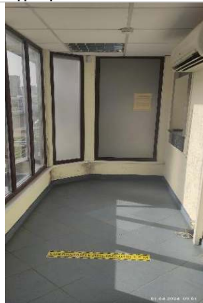
Фотография 6. Фрагменты внутренних помещений объекта оценки
