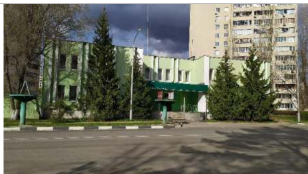
Фотография 3.17. Фасад административного здания
