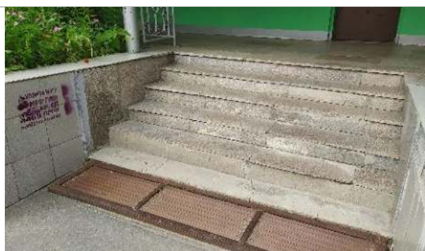
Фотография 17. Входная группа по состоянию на 15.02.2019 г.
