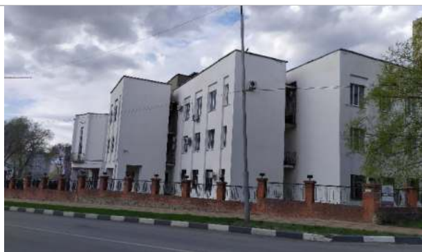
Фотография 11. Окружающая застройка, подъездные пути
