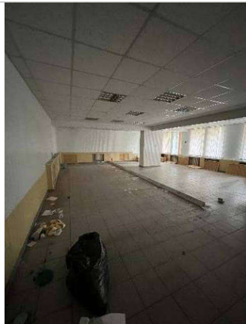
Фотография 54. Внутренние помещения здания
