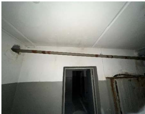
Фотография 17. Внутренние помещения здания
