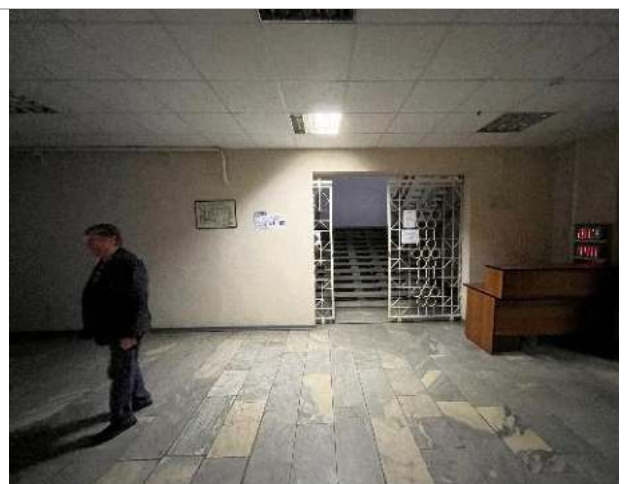
Фотография 44. Внутренние помещения здания
