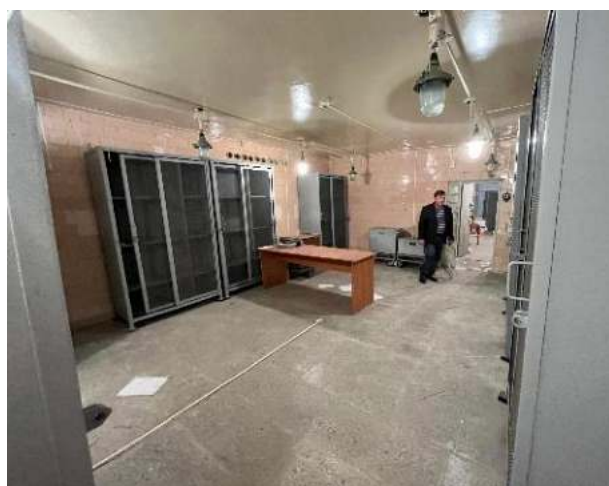
Фотография 32. Внутренние помещения здания
