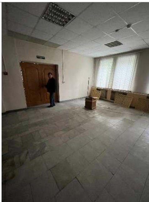
Фотография 46. Внутренние помещения здания
