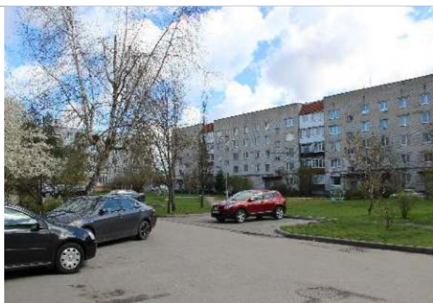
Фотография 5. Подъездные пути, прилегающая территория
