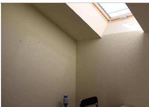
Фото 26. Внутренние помещения объекта.
