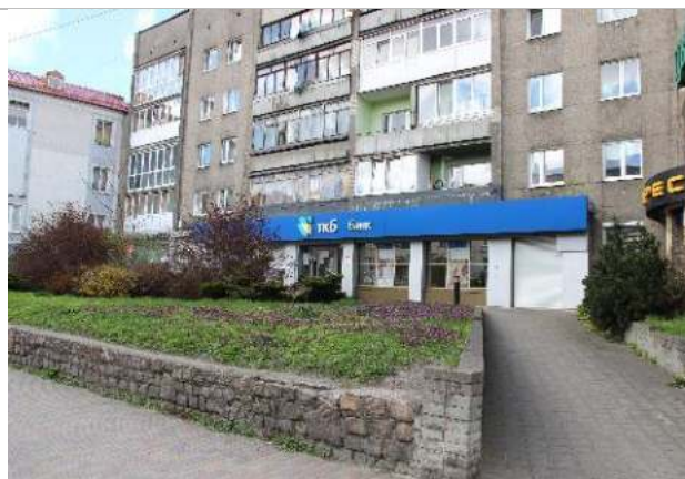
Фотография 3.13. Внешнее состояние объекта
