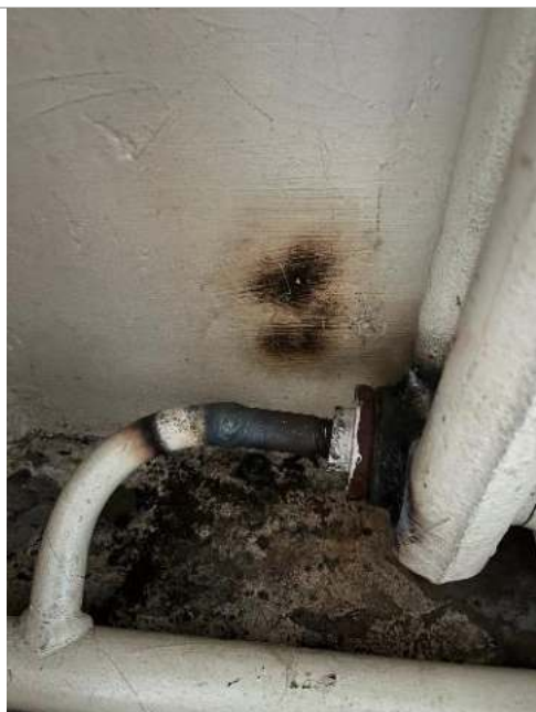
Фотография 57. Внутренние помещения здания
