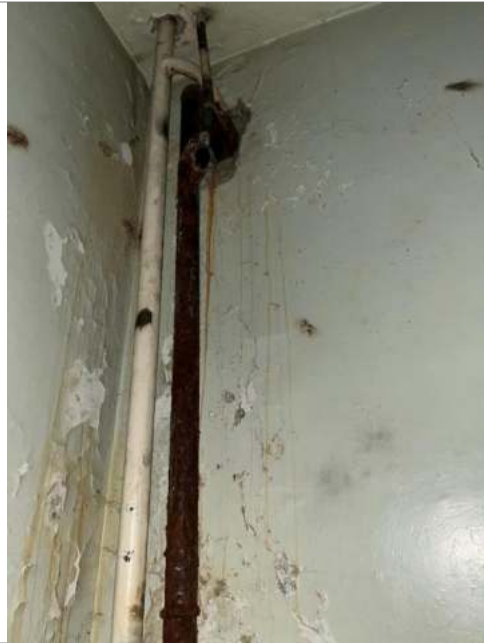
Фотография 39. Внутренние помещения здания
