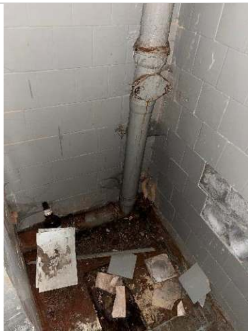
Фотография 23. Внутренние помещения здания
