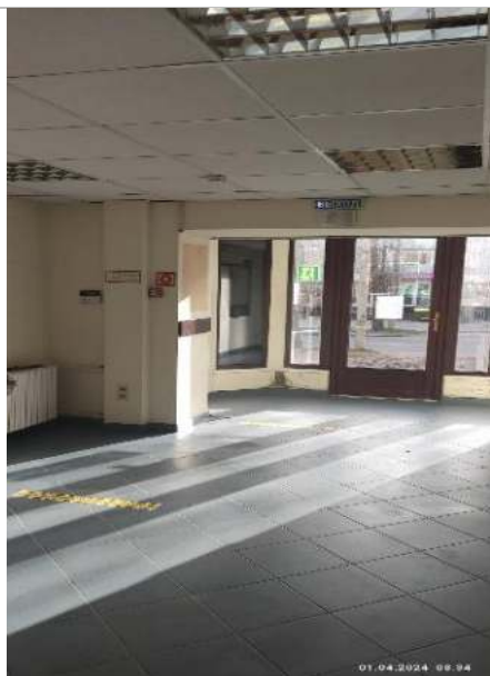
Фотография 7. Фрагменты внутренних помещений объекта оценки
