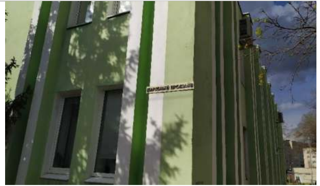
Фотография 6. Фасад здания
