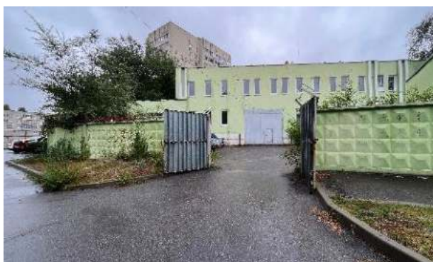
Фотография 8. Гараж, подъездные пути
