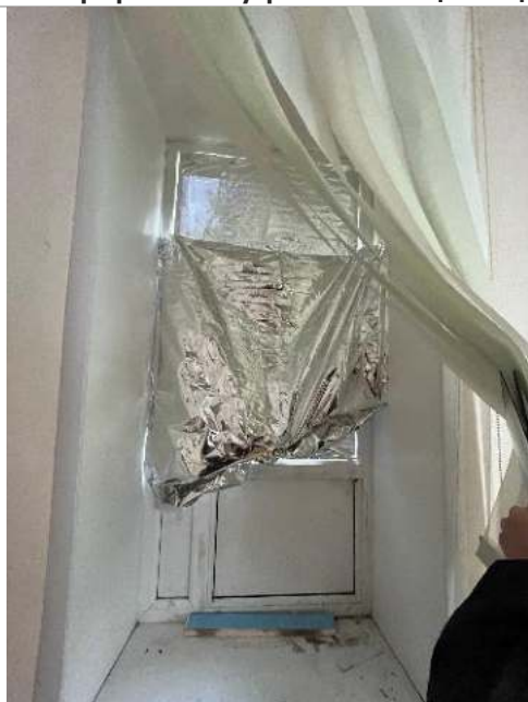
Фотография 47. Внутренние помещения здания
