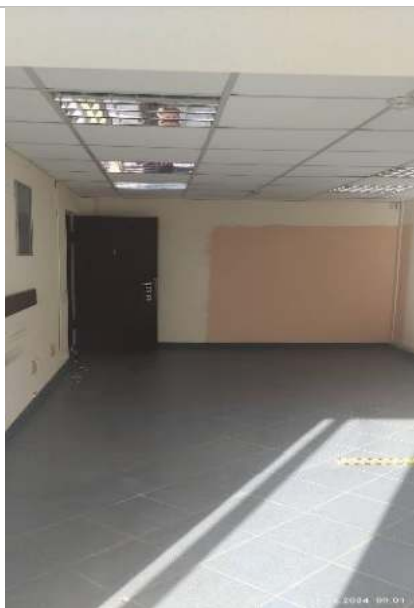
Фотография 8. Фрагменты внутренних помещений объекта оценки
