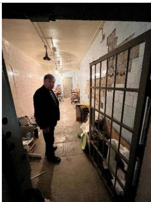
Фотография 31. Внутренние помещения здания
