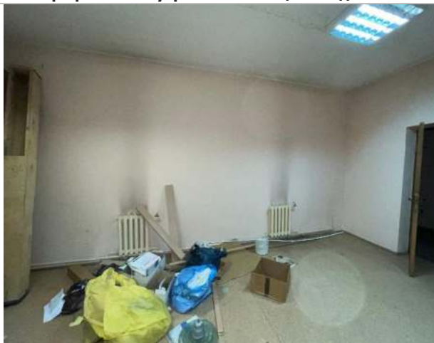
Фотография 50. Внутренние помещения здания
