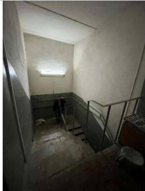
Фотография 14. Внутренние помещения здания
