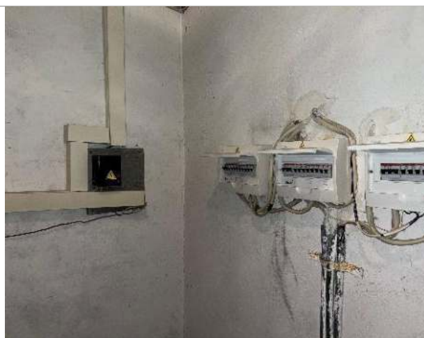
Фотография 64. Внутренние помещения здания
