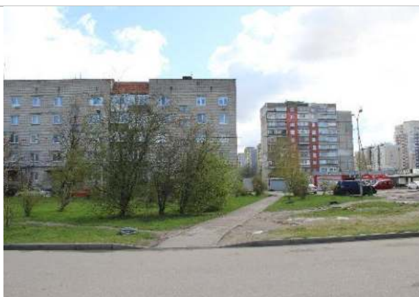
Фотография 6. Подъездные пути, прилегающая территория
