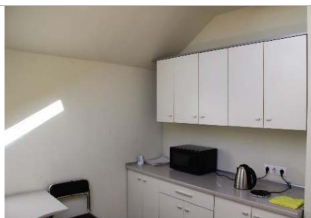
Фото 25. Внутренние помещения объекта.
