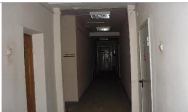
Фотография 16. Внутренние помещения по состоянию на 15.02.2019 г.
