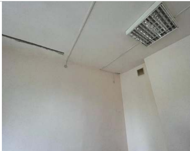
Фотография 55. Внутренние помещения здания
