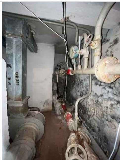
Фотография 61. Внутренние помещения здания
