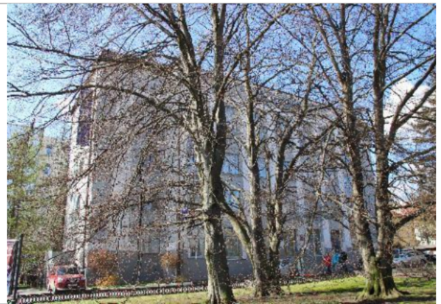
Фотография 10. Внешнее состояние объекта.
