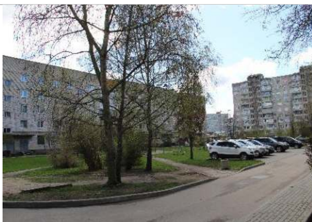
Фотография 4. Подъездные пути, прилегающая территория
