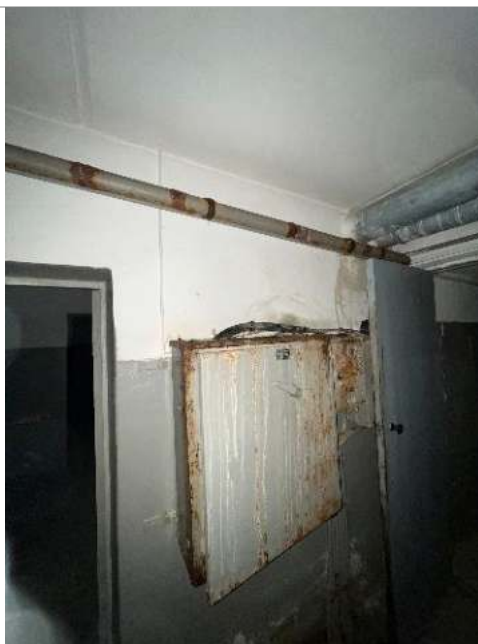
Фотография 18. Внутренние помещения здания
