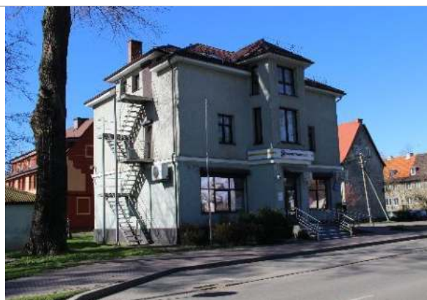
Фотография 3.5. Внешнее состояние объекта
