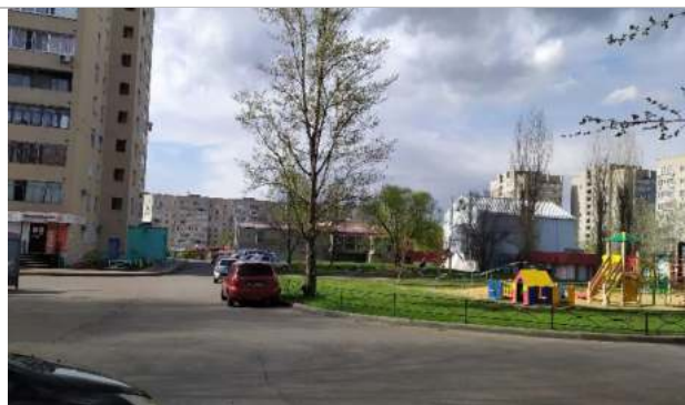
Фотография 13. Окружающая застройка, подъездные пути
