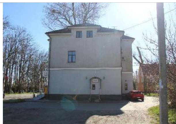
Фотография 3.6. Внешнее состояние объекта
