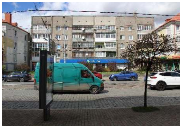
Фотография 19. Подъездные пути
