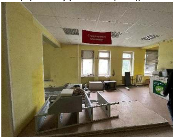
Фотография 38. Внутренние помещения здания
