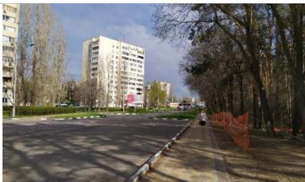
Фотография 14. Окружающая застройка, подъездные пути
