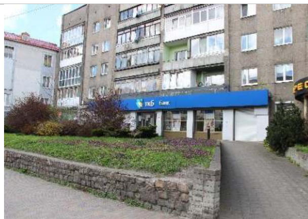
Фотография 3.14. Внешнее состояние объекта
