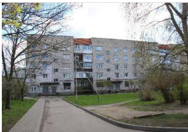
Фотография 3. Подъездные пути, прилегающая территория
