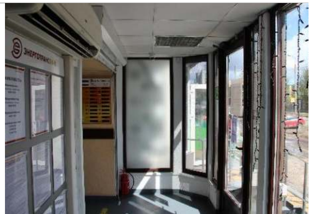
Фотография 12. Фрагменты внутренних помещений объекта оценки
