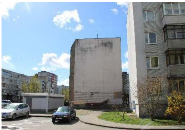
Фотография 2. Подъездные пути, прилегающая территория
