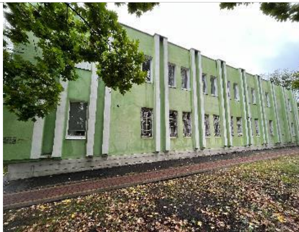
Фотография 3. Фасад здания
