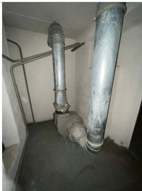
Фотография 62. Внутренние помещения здания
