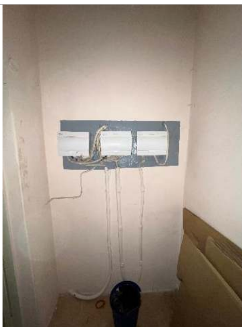
Фотография 60. Внутренние помещения здания
