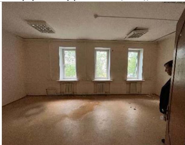
Фотография 49. Внутренние помещения здания
