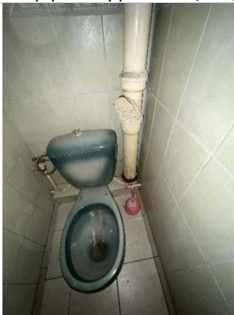
Фотография 48. Внутренние помещения здания
