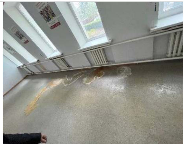
Фотография 42. Внутренние помещения здания
