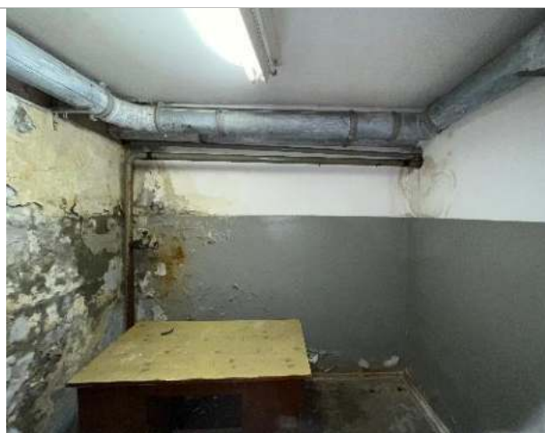
Фотография 63. Внутренние помещения здания
