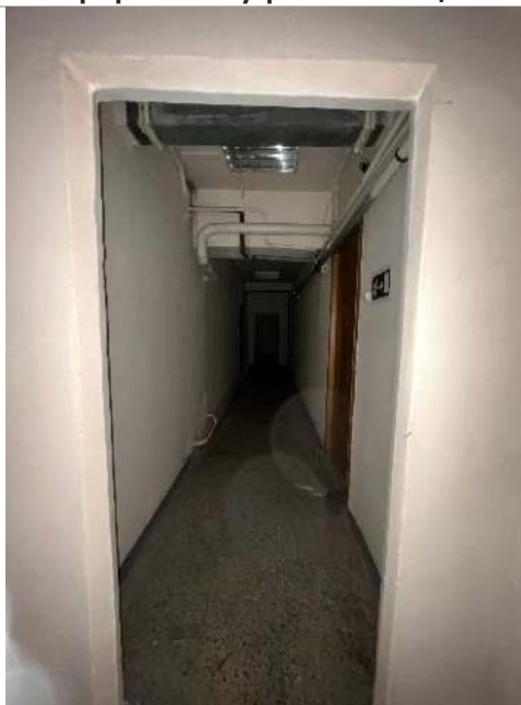
Фотография 36. Внутренние помещения здания
