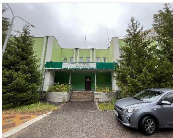
Фотография 5. Фасад здания
