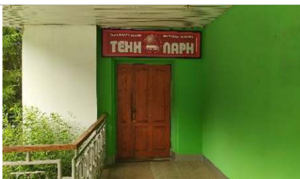
Фотография 18. Входная группа по состоянию на 15.02.2019 г.
