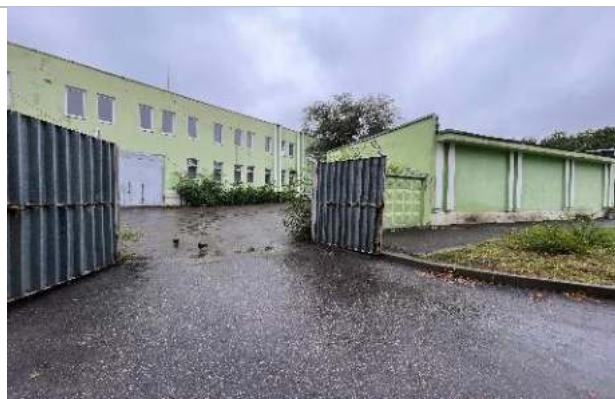
Фотография 7. Гараж, подъездные пути
