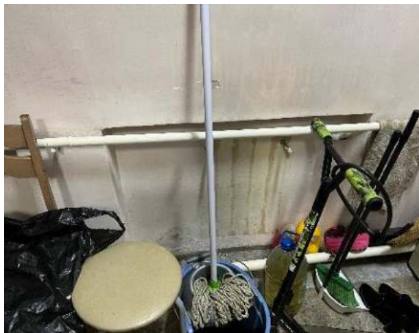
Фотография 29. Внутренние помещения здания
